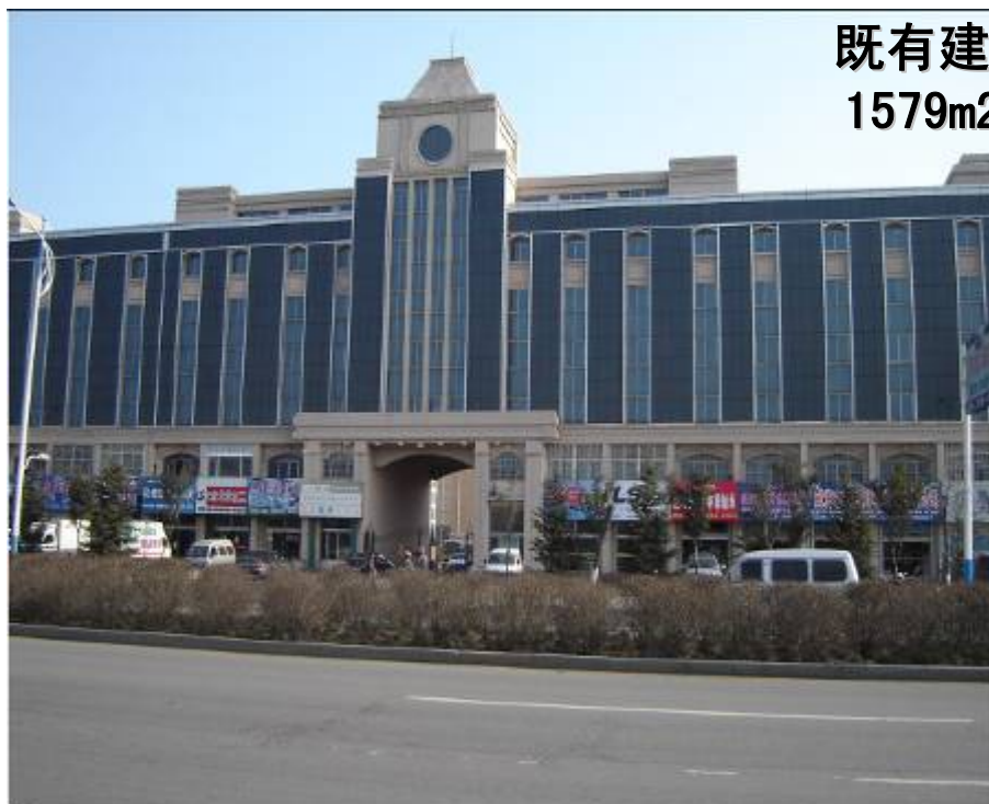
西立面实景照片
