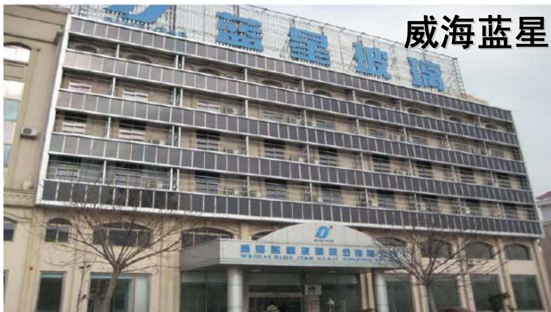
南立面实景照片
