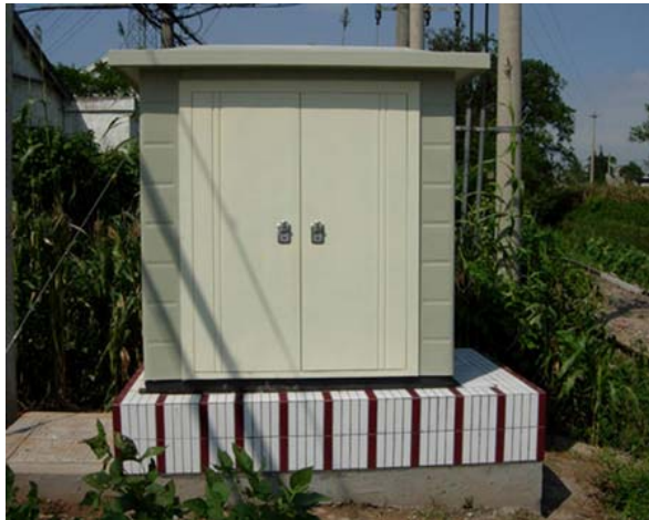
图 7-7 插卡式 ONU 室外机柜安装图
