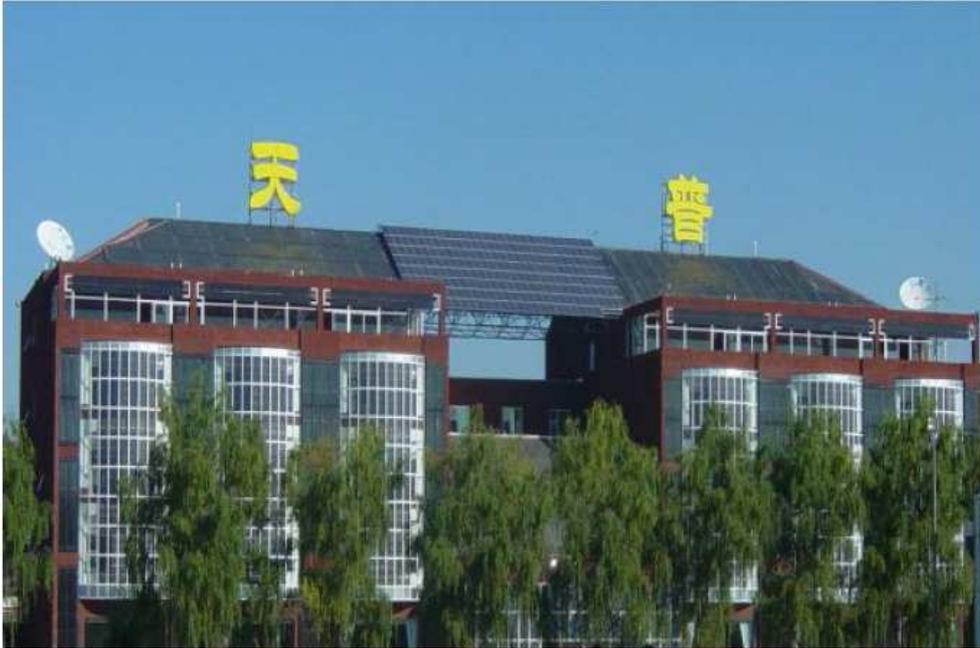
北京科诺伟业科技有限公司开辟了我国BIPV 应用的先例。2003 年首先研制开发了北京大兴天普大厦50kWp 的BIPV 示范系统，这是我国最早真正意义上的光伏与建筑结合的系统。这一系统采用了各种不同的光伏电池，对各种材质、各种设计参数分别进行了考核，其中包括单晶硅和多晶硅光伏电池组件、多结非晶硅薄膜光伏电池组件、硒铟铜（CIS）薄膜光伏电池组件等。该项目的成功为以后更大规模的光伏建筑一体化的设计奠定了基础。
