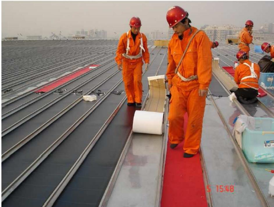
首都博物馆新馆作为北京的标志性建筑物，是市政府奥运工程配套项目中的重点工程。为了更好地将建筑与艺术、建筑与高新技术的相结合，努力创造绿色、环保、节能的城市整体形象，在市领导和有关部门的支持下，根据大平顶、大挑檐结构的建筑屋顶设计，在首博新馆屋顶的平面部分安装了5000 平方米的太阳能柔性光伏组件，峰值发电量达到了300KWp，使中国太阳能光伏发电工程中单体建筑发电量达到了国际先进水平。首博新馆也成为集节能、环保与高科技为一体的、充满现代气息的博物馆，具体形象地表现了太阳能资源的利用，以求可持续发展的教育示范作用。
