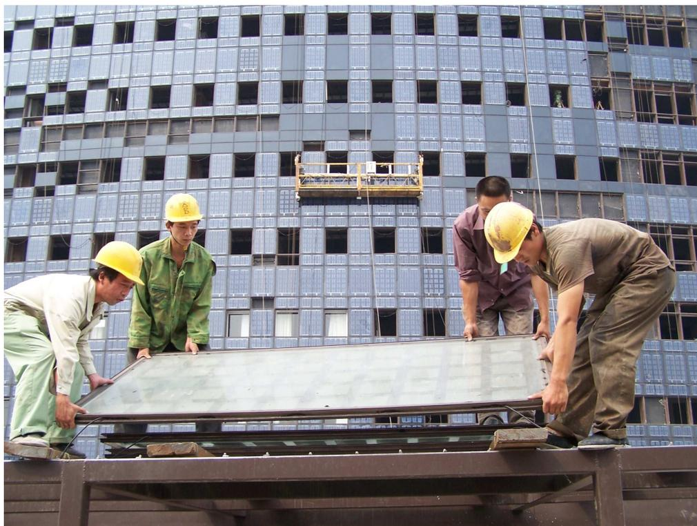
国内首座太阳能光伏并网发电与星级酒店一体化建筑—保定市高开区电谷锦江国际酒店，大规模、多角度应用太阳能光伏发电技术，让高耗能的酒店大厦变成了输出电力的电站。
