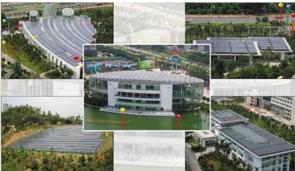
“十五”期间，中国科学院电工研究所承担了国家863项目；与建筑结合的兆瓦级并网光伏发电关键技术研究课题。在此基础上，由深圳市政府投资，中国科学院电工研究所北京科诺伟业科技有限公司研制建设了深圳国际园林花卉博览园1MWp并网光伏电站，电站容量为1MW，已于2004年8月并网发电。这是目前中国建成的最大光伏并网系统，这是一个低压用户端并网系统，安装在四个建筑的屋顶和一个山坡上。与建筑物结合的太阳能光伏发电系统在我国是新兴的高技术产业，深圳国际园林花卉博览园1MWp并网光伏电站，填补了我国在兆瓦级并网光伏系统设计和建设上的空白，成为我国在光伏系统与建筑相结合树立了典范，具有良好的示范效果。
