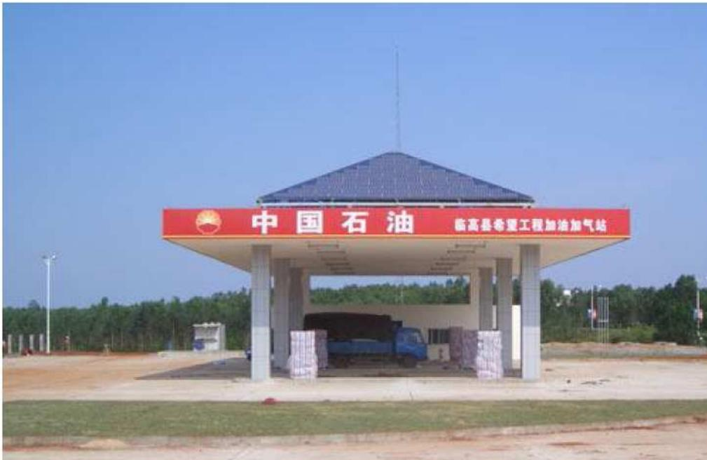
海南希望工程加油站并网光伏电站项目已于2007年1月完工。该项目设计在海南希望工程加油站屋顶，为加油站的电气设备供电使用。该电站总容量为25kWp，每年的发电能力约为36,000kWh（3.6万度），按设计寿命25年计算，寿命期内共产生约91万度的电能，与火力发电相比，相当于累计节约标准煤约350吨，减排158吨二氧化碳、7吨二氧化硫、5吨粉尘和94吨灰渣。
