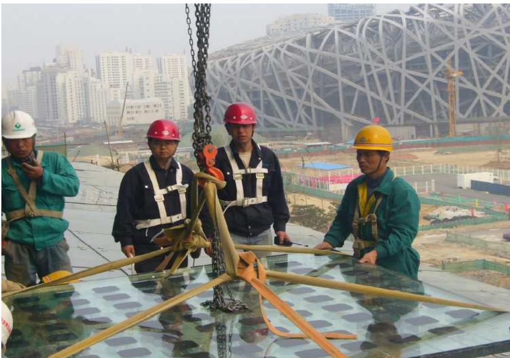
北京奥运国家体育馆的100kWp 并网光伏发电系统，是真正意义上的光伏与建筑集成系统。按照光伏系统的安装方式，可分为两部分：一部分采用常规的晶体硅太阳能电池，安装在体育馆屋顶的采光带上，容量约为90kWp；另一部分采用双玻太阳能电池组件，安装在国家体育馆南立面上，代替部分玻璃幕墙，容量约为10kWp。
