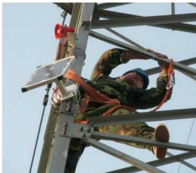
设备安装施工照片
